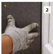
2. Pose de l'isolant en tableaux de fenêtres/portes.
