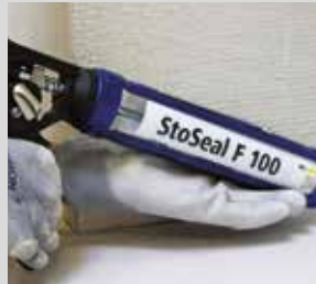
Application de StoSeal F100 sur fond de joint.
