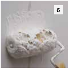
6. Traitement des fissures et des joints.
