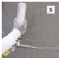
5. Traitement des joints de plaques.
