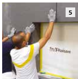
5 Ensuite, poser l'isolant en façade, sans oublier les coupes en L autour de la fenêtre.
