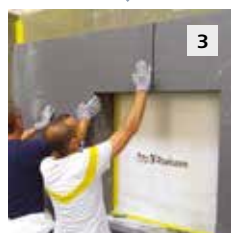
3. Pose de l'isolant en façade.
