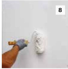
8. Application du revêtement.
