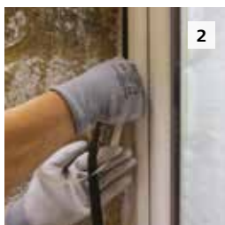
2 Poser des Sto-Compriband sur le dormant de la fenêtre.
