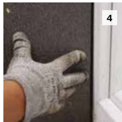
4 Plaquer l'isolant au support.
