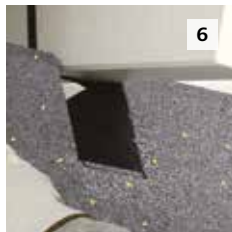
6. Jonctions entre isolant et autres matériaux.
